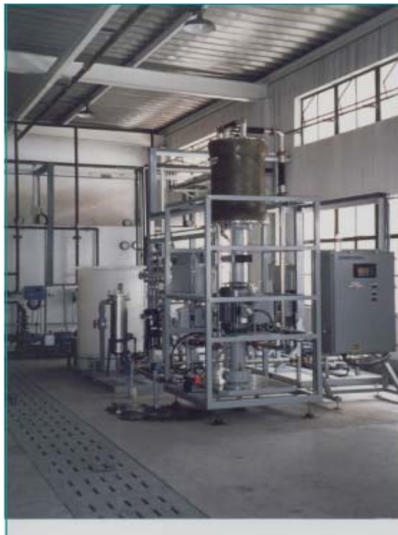
V◇SEP Membransystem installiert bei einer bedeutenden Kläranlage für die Filtration von ölhaltigem Wasser
