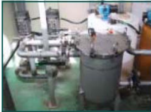
Beutelfilter, Zubringerpumpen und chemische Dosierpumpen für Reinigungsmittel
